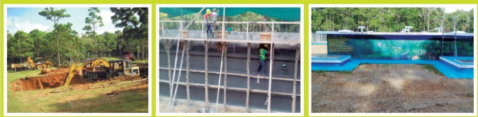
Etapas constructivas del Tanque de Almacenamiento
