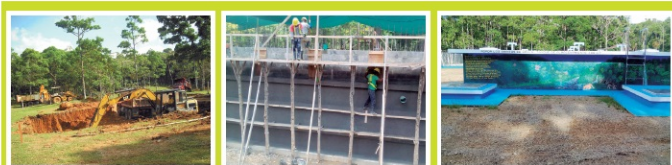
Etapas constructivas del Tanque de Almacenamiento
